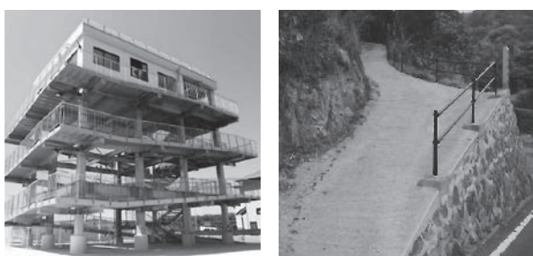
津波避難タワーや避難路の整備
